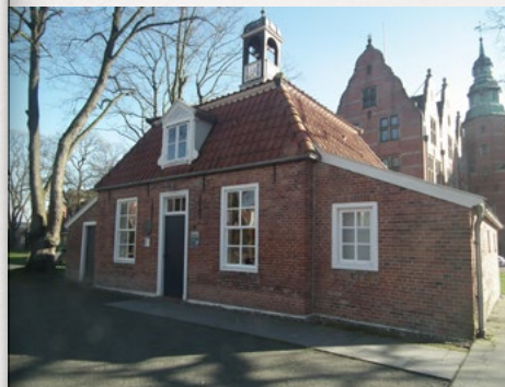
Pingelhus, ein ehemaliges Hafenwärterhaus
